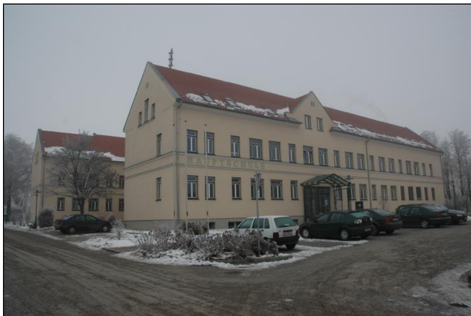
Abb. 15: Hauptschule Gaweinstal (nach Sanierung bzw. Erweiterung)
