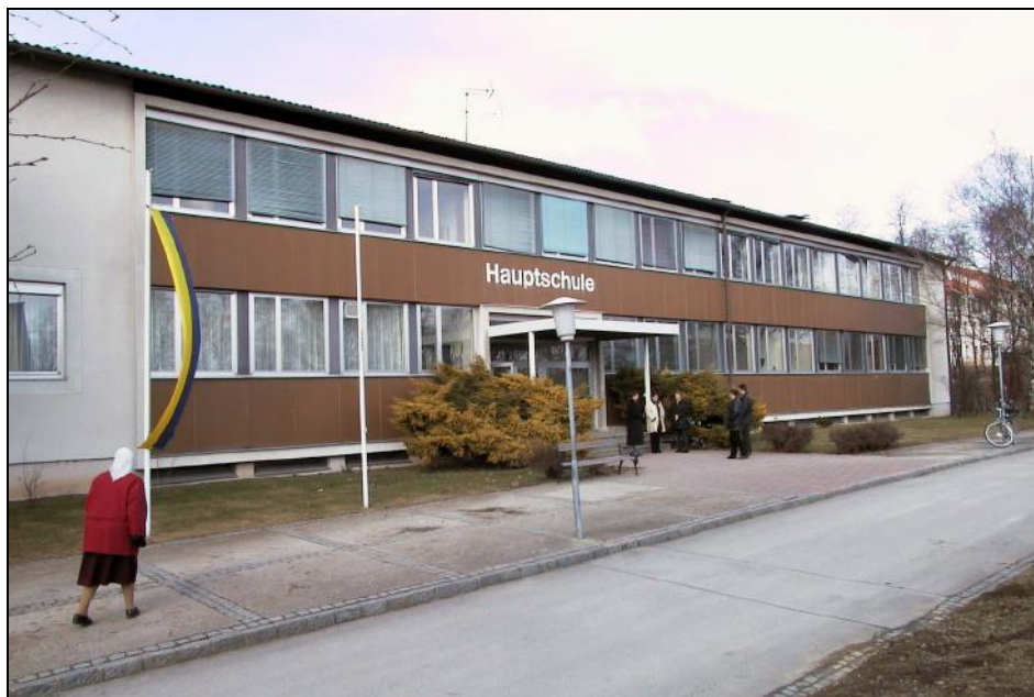
Abb. 14: Hauptschule Gaweinstal (vor Sanierung bzw. Erweiterung)
